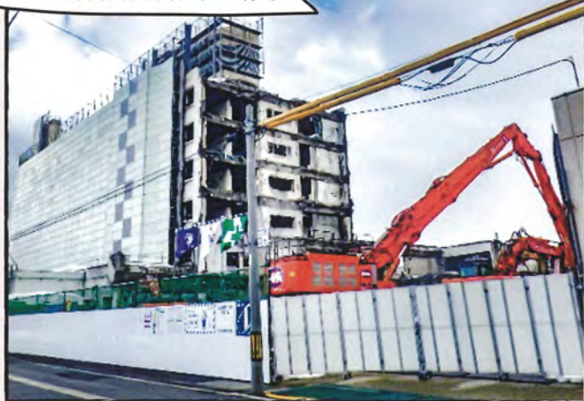
旧一般病棟解体中の様子
